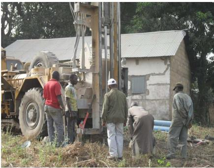
Con tu aportación del pasado año, has colaborado en la construcción de dos pozos en **Togo**. Actualmente se han terminado las perforaciones y se inicia la fase de construcción de los depósitos y colocación de las bombas manuales y fotovoltaicas. También se trabaja con los Comités de Agua y en la formación de los usuarios.
