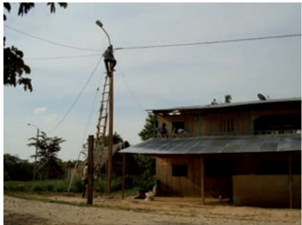
Foto 2: instalación de redes secundarias
