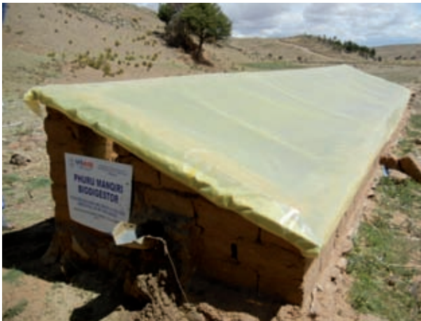
Foto 1: Biodigestor instalado en la zona del lago Titicaca en Bolivia
