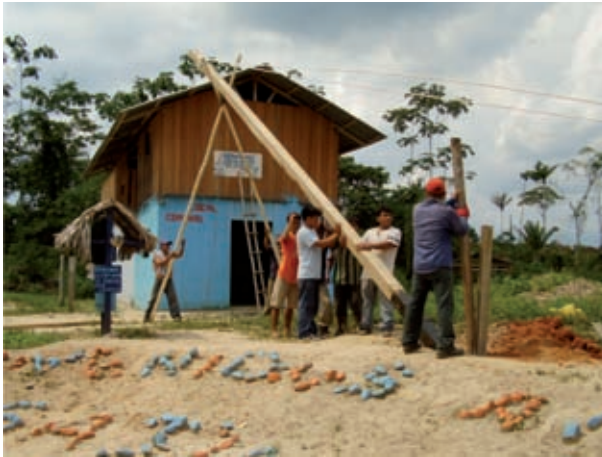
Foto 1: Instalación de postes para alumbrado público
